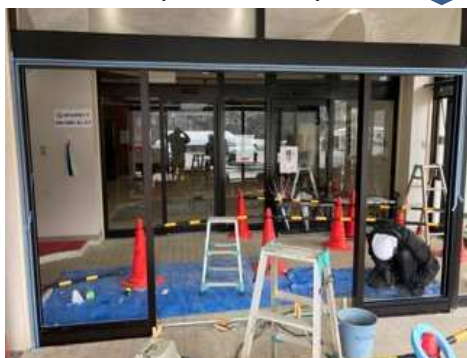
③ 施工中(両袖FIX取付)
