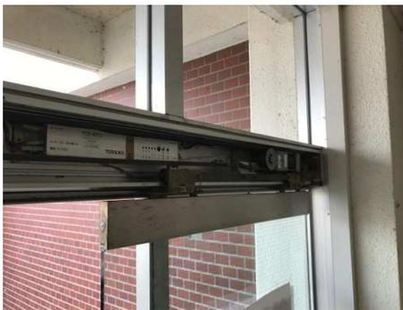
③ 老朽化自動ドア開閉装置撤去
