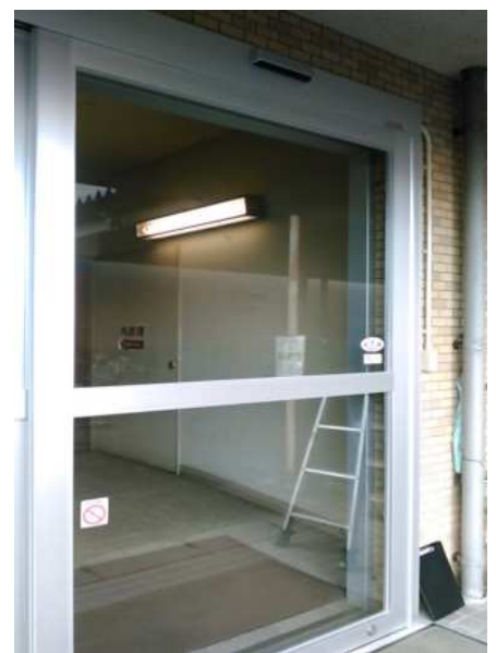
⑥ 新規自動ドア装置設置完了
