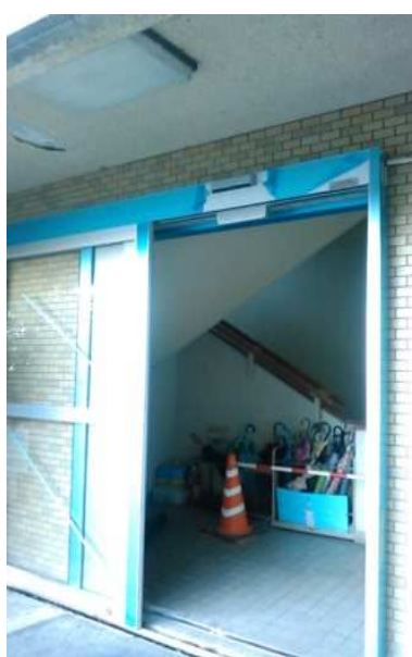
⑤ 施工中(外観)
