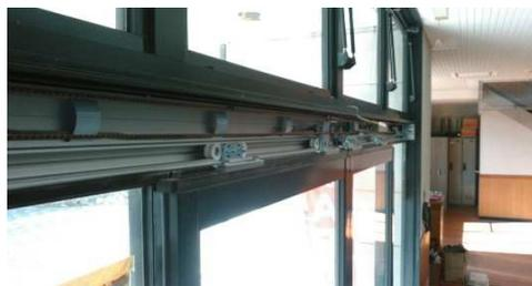
・無目の中に、新しい自動ドア開閉装置を取り付け、内外起動センサ、補助センサも交換して、ドア吊り込み調整。
