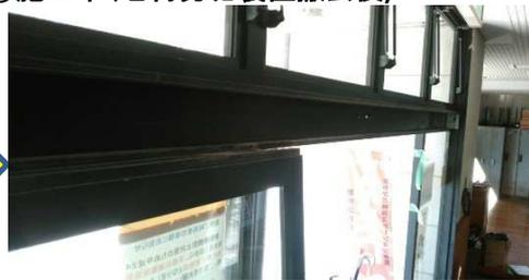
・老朽劣化し、故障したままの自動ドア開閉装置を手動で利用していましたが、無目内部から装置を全て撤去。
