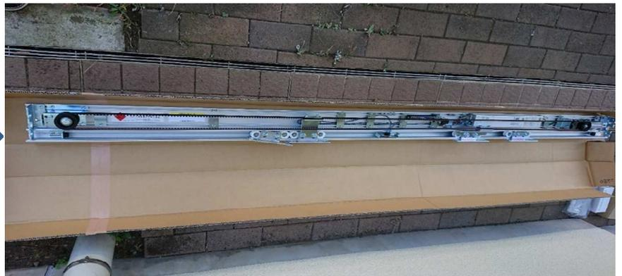
自動ドア開閉装置と内外センサ、補助センサ(光電センサ)一式を交換しました。
