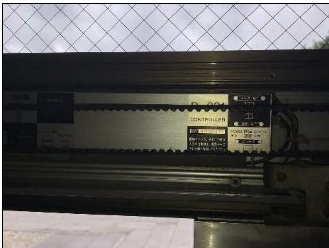
自動ドア開閉装置(制御部)
