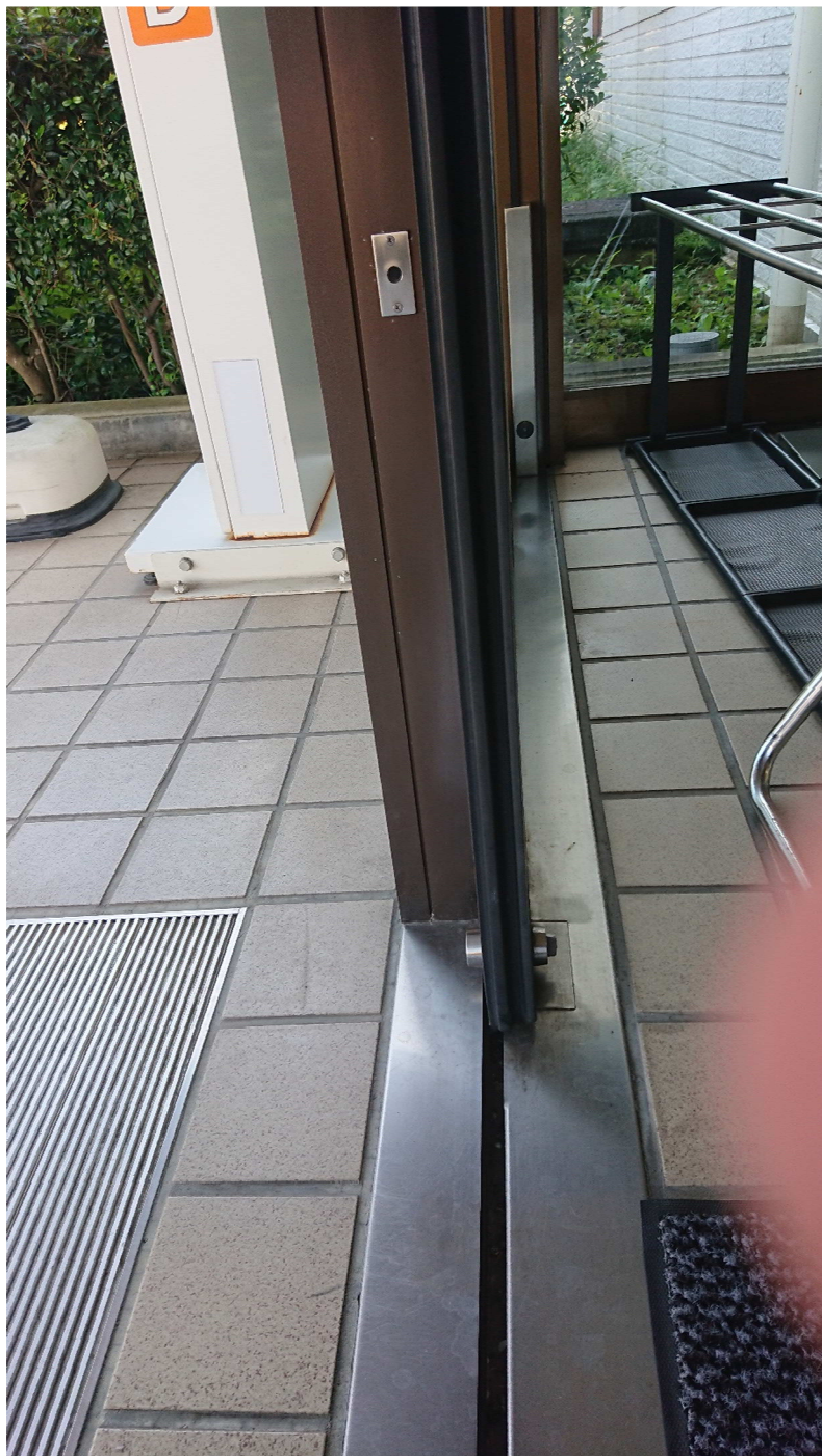
補助光線センサ、扉とガイドレール、使途不明光電センサの様子
