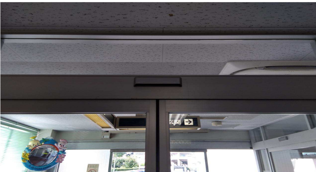
補助光線センサ（対向式3光線、FLより200mm、400mm、900mm）
