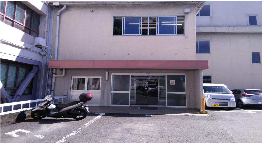
自動ドアフロント外観
