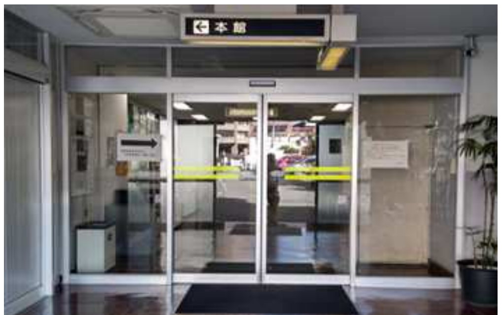
⑨ 施工完了 (外観)
