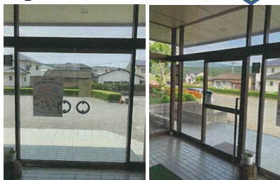
③ 施工中(フロント撤去)
