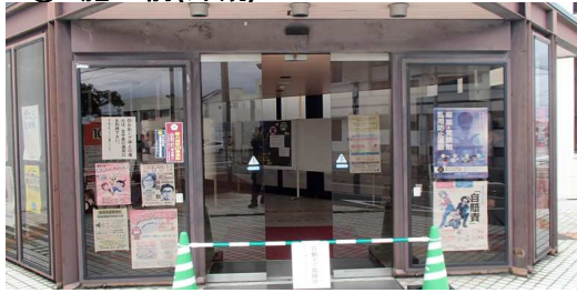
② 施工中(内観)
