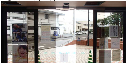
③ 施工中(自動ドア開閉装置)
