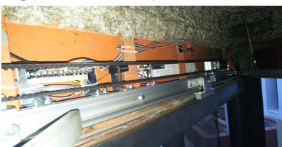
⑦ 施工中(新規装置取付)
