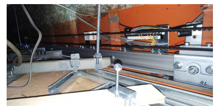
⑧ 施工中(新規装置取付)
