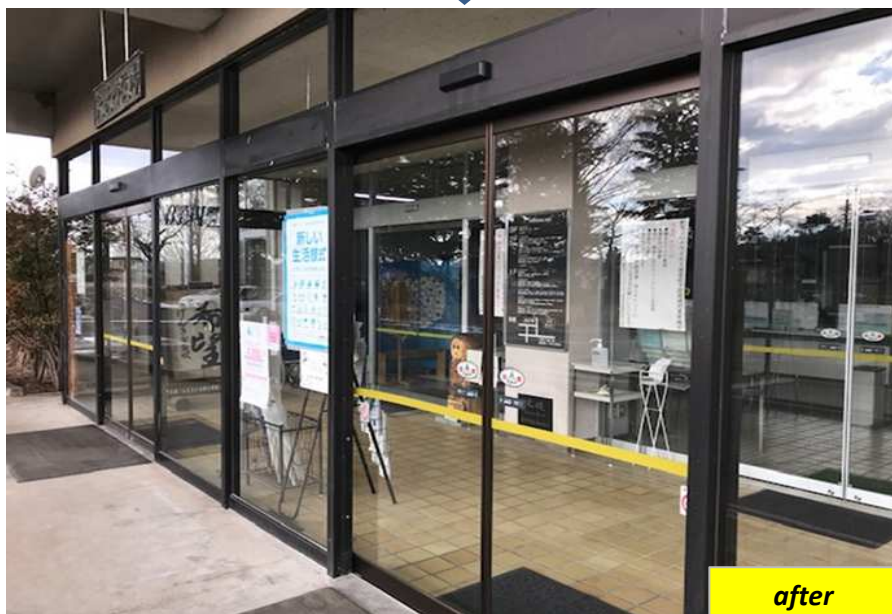
⑩ 自動ドア化工事完了
