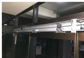
⑧自動ドア開閉装置
