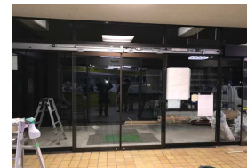
⑨ドア吊り込み
