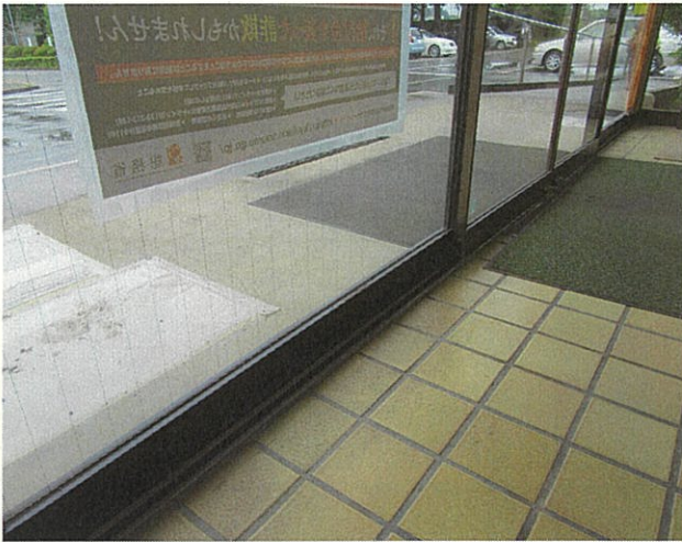
既設自動ドア内側正面下部
