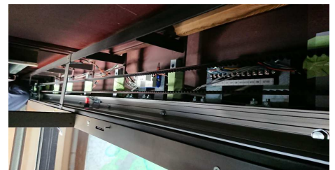
⑧新規自動ドア開閉装置の納り
