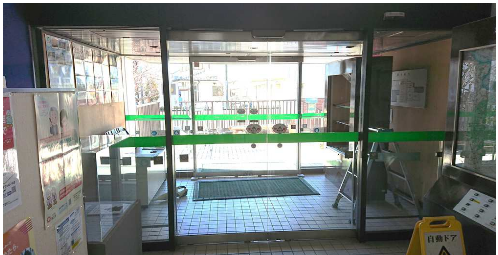
⑨ 無事に設置完了
