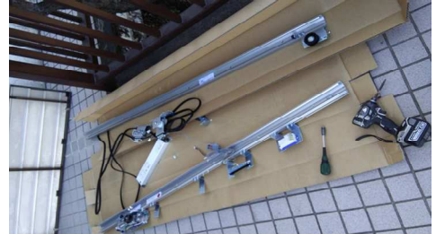
⑧新規自動ドア開閉装置の納り
