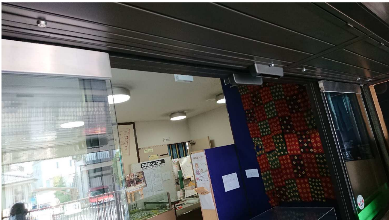
風除室天井（点検口）の様子
