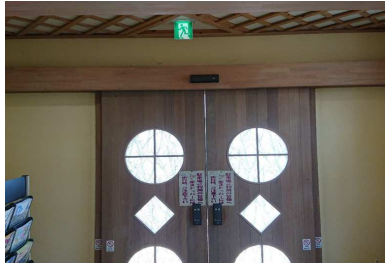
②老朽化自動ドア装置
