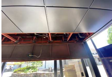
③老朽化自動ドア装置
