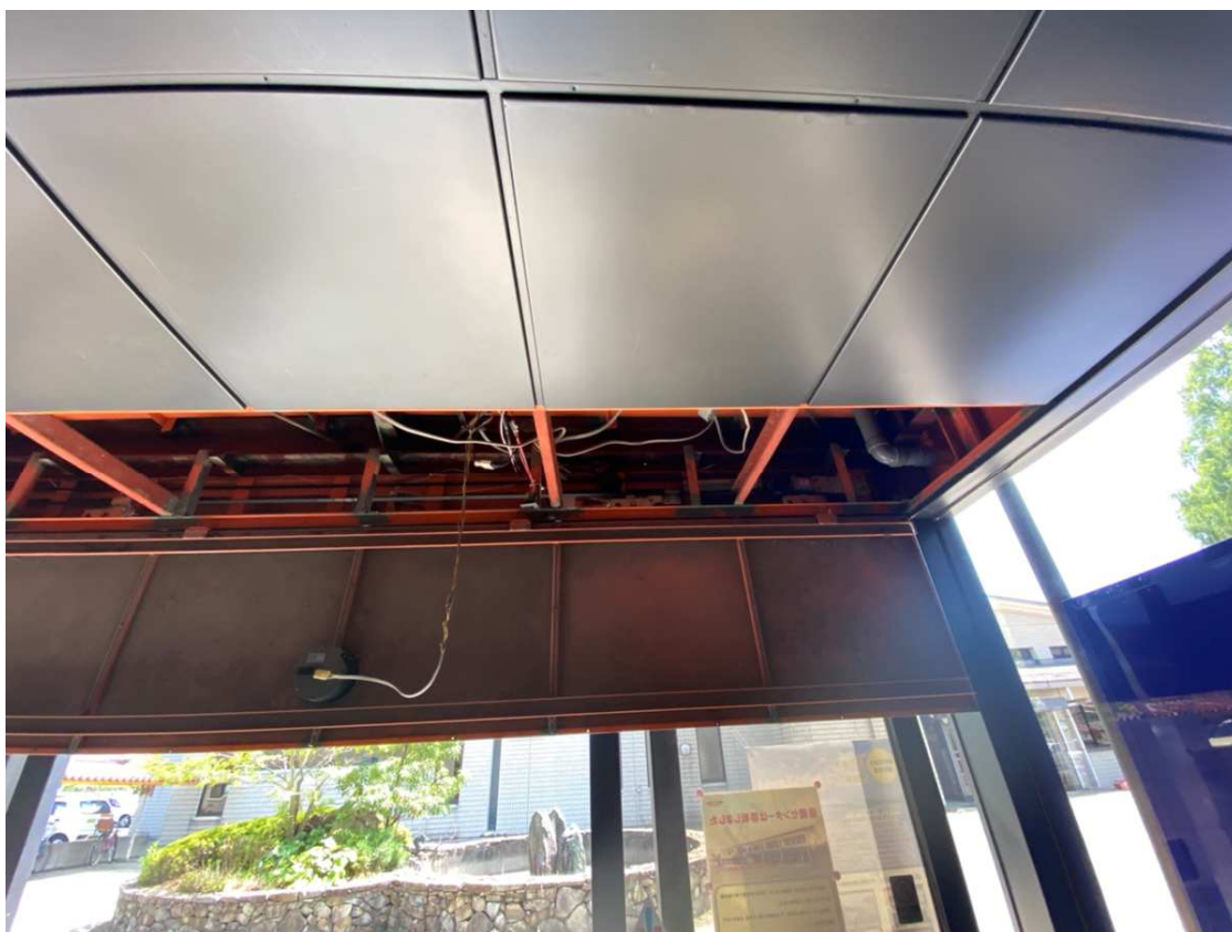
内側天井埋め込みセンサ / 外側無目下取付センサ
