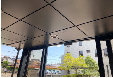
②天井裏納まりの様子
