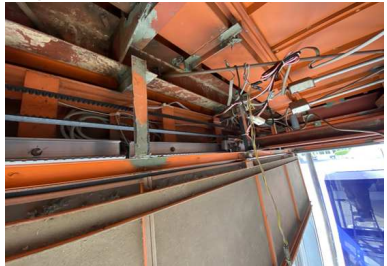
④自動ドア装置撤去
