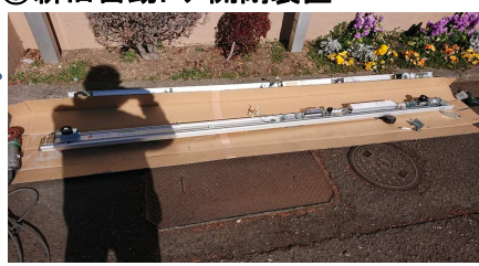
⑥ドア吊り調整中
