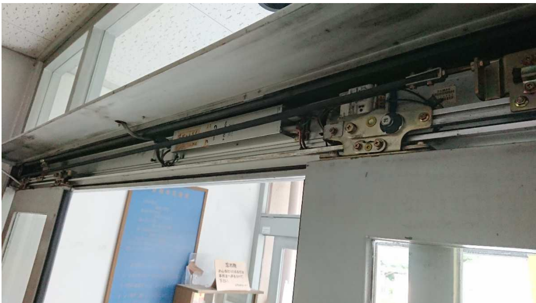
左側ブラケットの様子：金具で台板を押さえつけて固定します。
