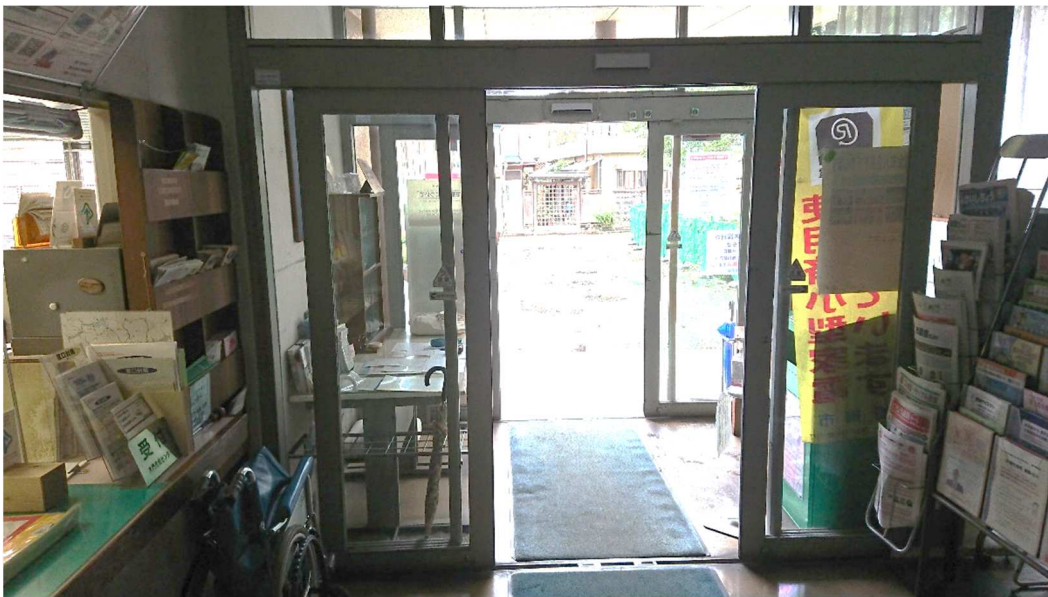
自動ドア装置内部の様子)
