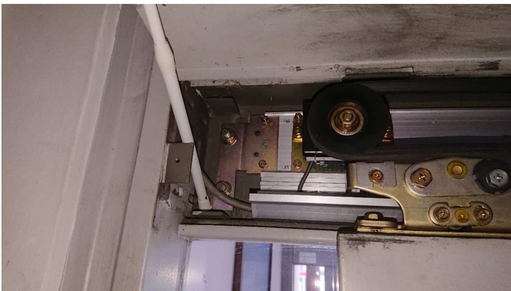
左側ブラケットの様子：金具で台板を押さえつけて固定します。
