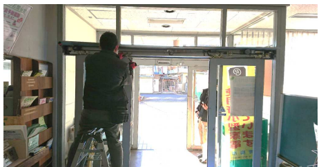
④自動ドア開閉装置撤去
