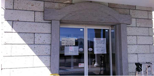
②施工前の様子(内観)
