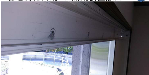
④老朽化自動ドア開閉装置撤去
