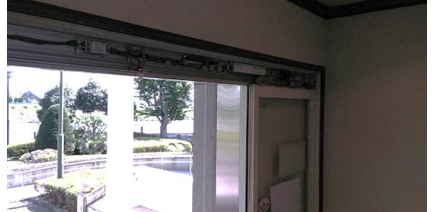
⑧新規自動ドア開閉装置取付
