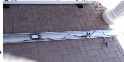
⑤撤去した自動ドア装置
