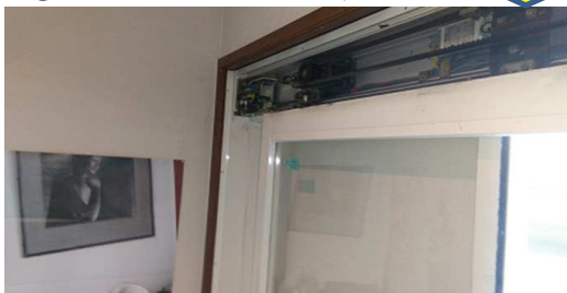
④老朽化自動ドア開閉装置撤去
