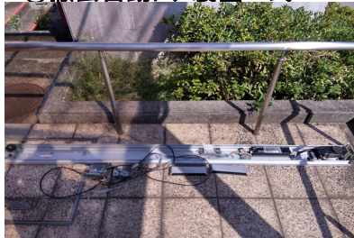
④撤去自動ドア装置一式
