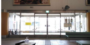
②施工前(風除室内側自動ドア)
