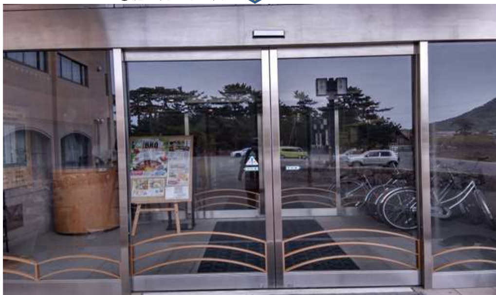
⑨施工完了(外観)
