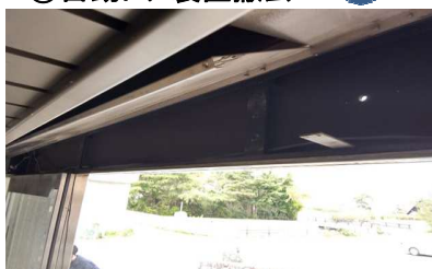
④自動ドア装置撤去
