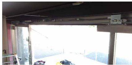
⑤新規自動ドア開閉装置取付
