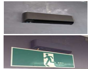
⑦自動ドア装置交換工事完了
