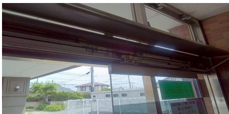
④新規自動ドア開閉装置
