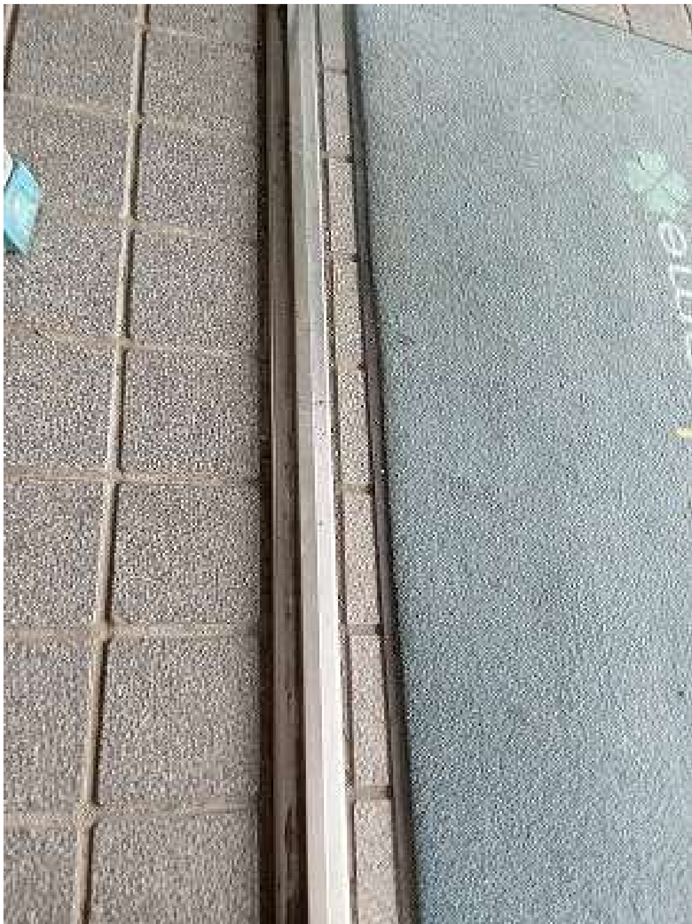
ガイドレールの状態
