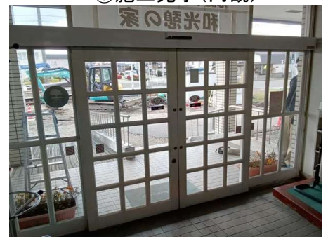
⑧施工完了(内観)
