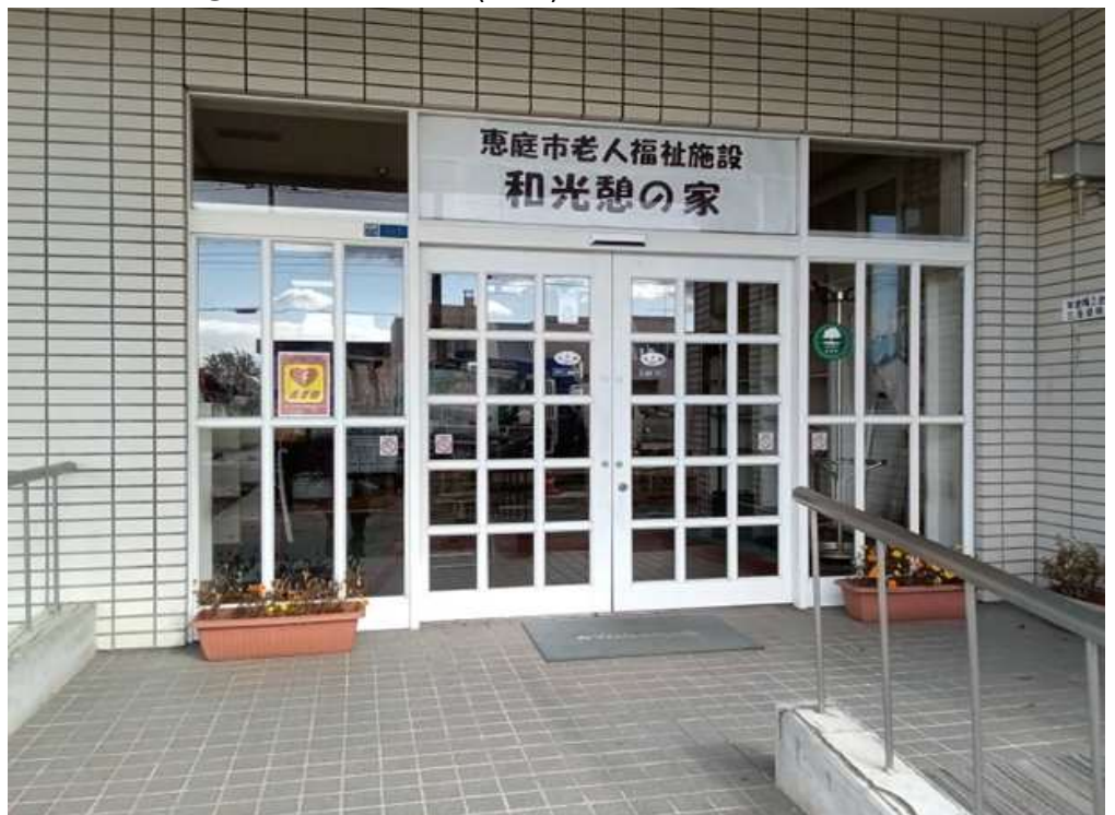
⑨自動ドア工事完了(外観)
