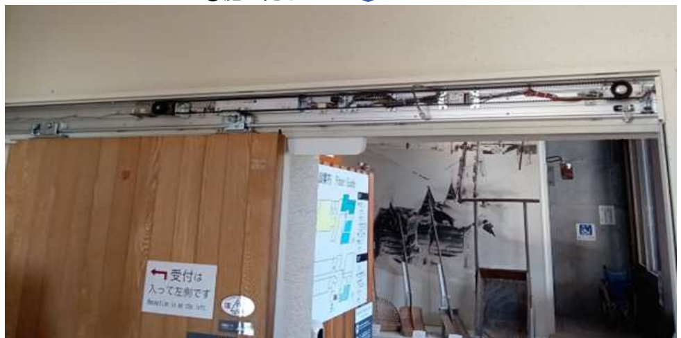
⑨施工完了
