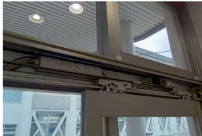
④ 自動ドア装置撤去
