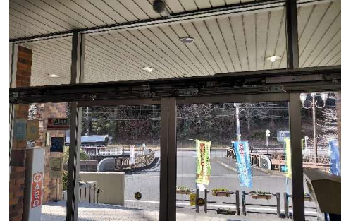
⑦新規自動ドア装置取付
