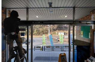
④老朽化装置撤去
