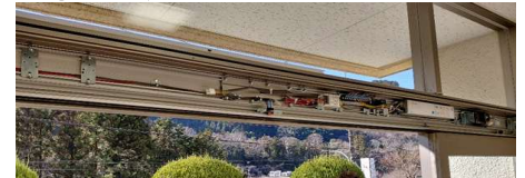
⑥ 開閉装置取付
