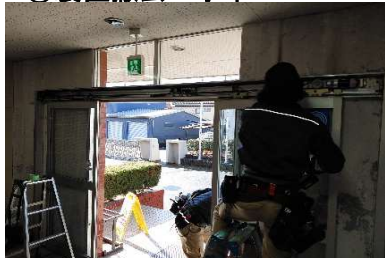
④ 自動ドア装置撤去
