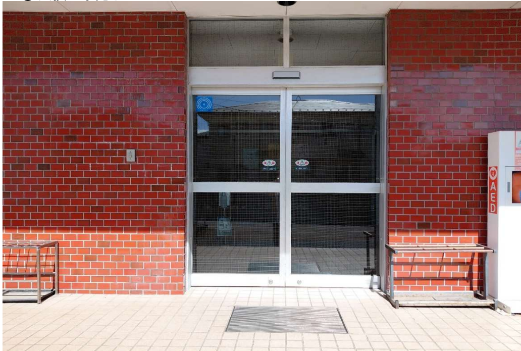
⑦ 交換工事完了
