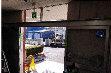
④ 自動ドア装置撤去
