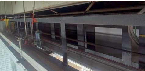
⑩自動ドア装置交換工事完了
