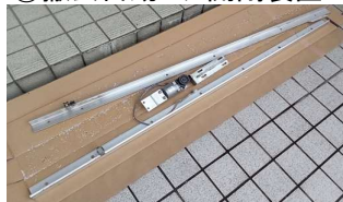
⑦新規自動ドア装置施工中
