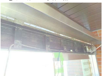
④自動ドア装置撤去
