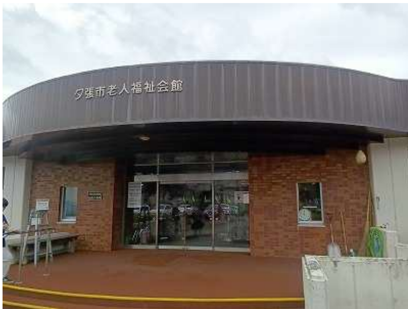
自動ドアフロント外観
