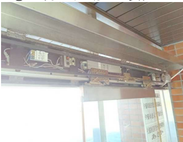
④自動ドア装置撤去
